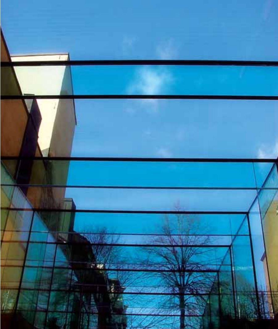
Bild 8. Bärande glaskonstruktion. Millimeter Arkitekters kontor i Stockholm.
