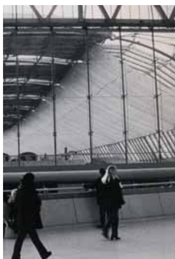
Bild 71. Waterloo station i London. Det undre härdade glaset i taket spontangranulerade och man har tvingats hänga tältliknande skycken under för att glas inte ska trilla ned på folk på stationen.
